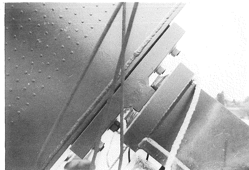
Fig. 6 Detail af spærfodsbeslag
