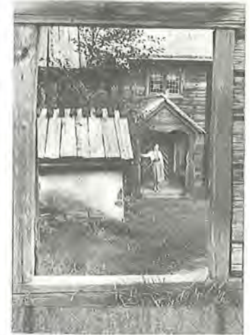
Karlsgården i Järvsö, Hälsingland. Ett fint byggnadsarv från 1600-talet.
