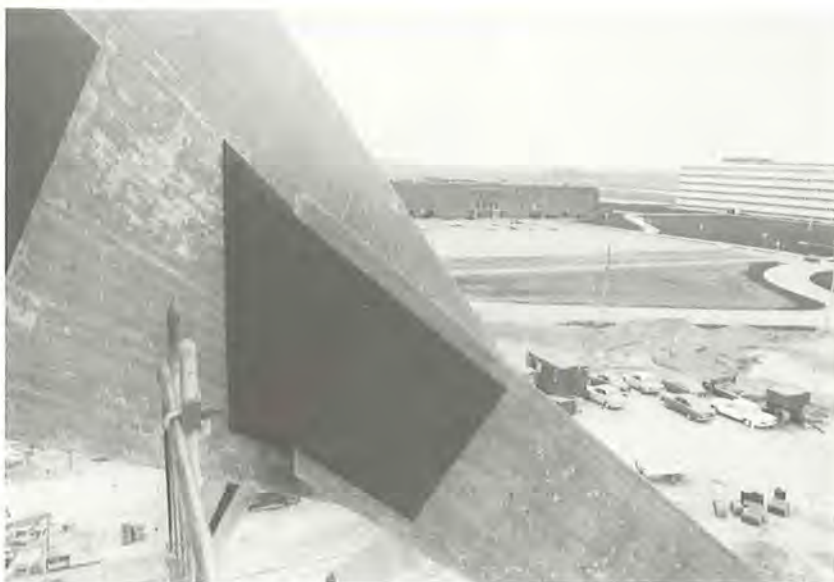
Fig. 8 Samling mellem grat og spær
