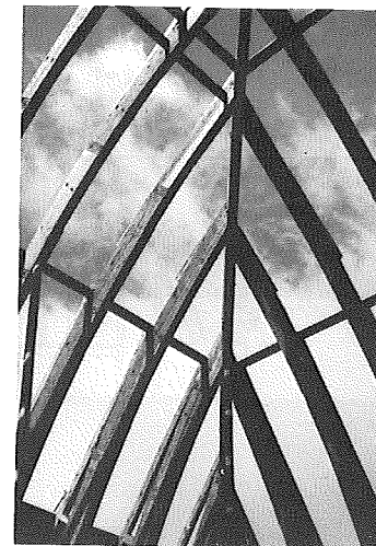
Ridehuset i Hørsholm. Del af tagkonstruktion under genopstilling. Foto: Mogens Koch, september 1939
