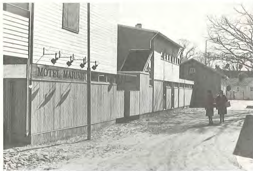
Figur 4. Motelllets fasad mot Kammakaregatan.
