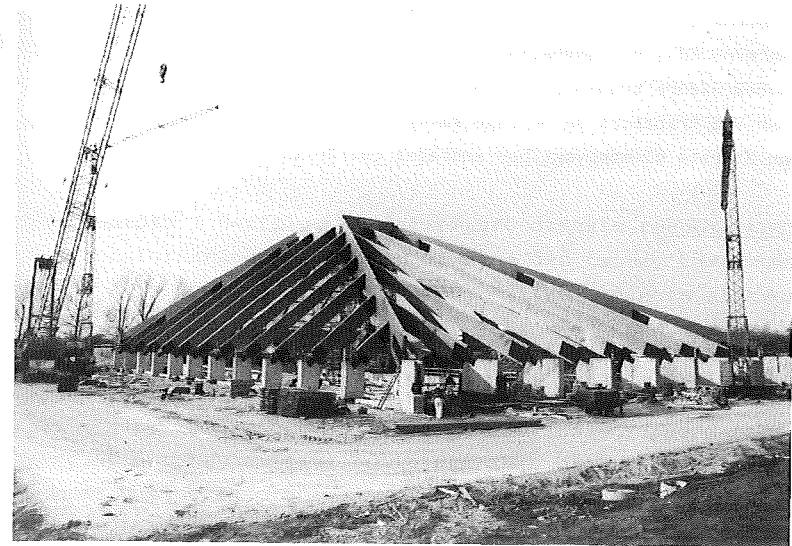
Fig. 11 Samtlige tagbjælker er monteret
