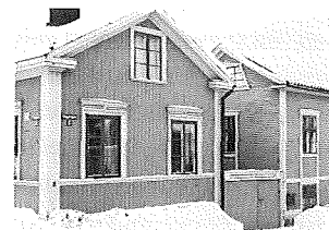
Plank eller portar sluter gaturummet.
